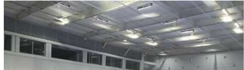
Ilustración 26. Detalle de luminaria LED para salas polivalentes y pabellones
