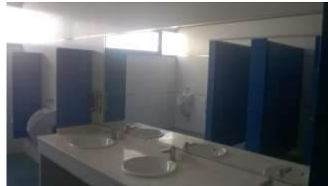
Ilustración 32. Detalle de nuevos vestuarios en El Batel
